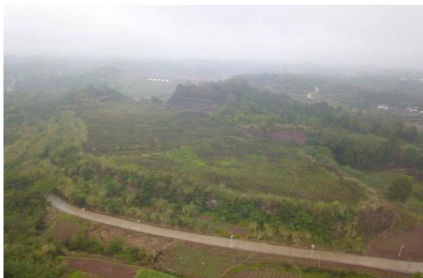
应家沟水库狮子湾料场
