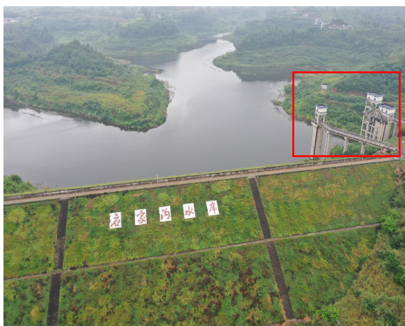
应家沟水库取水口与放空洞
