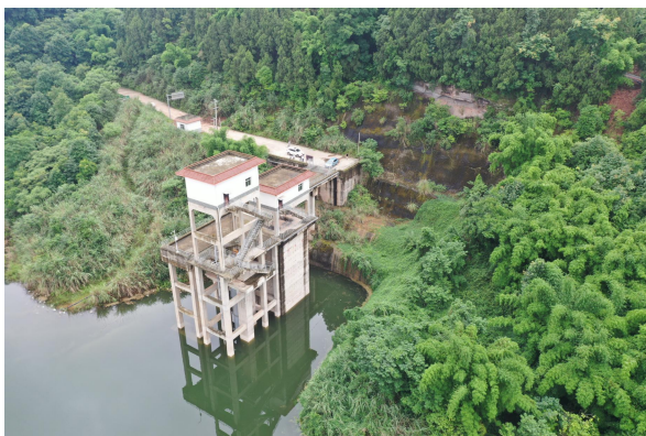
赵子河水库取水塔
