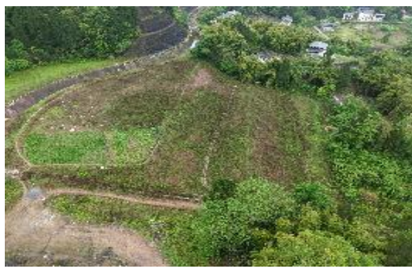
南充干渠五标段 2-6#渣场
