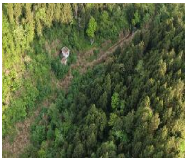
狗屎坪隧洞进口
