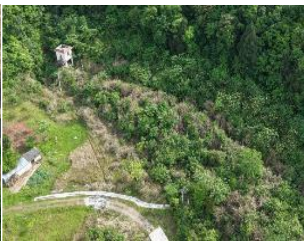
五龙支渠四方碑隧洞进口
