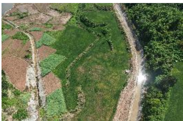
南充干渠四标段 2-2#渣场
