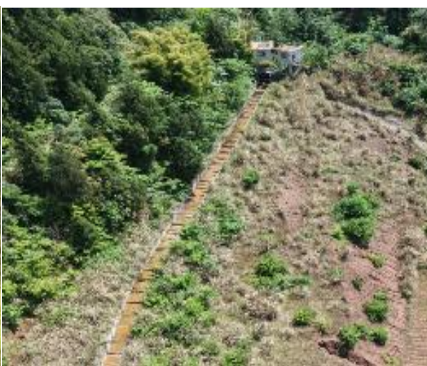
刘家山隧洞出口
