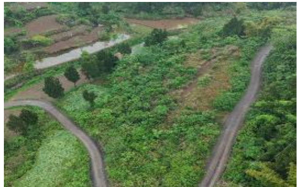
耳子山隧洞进口渣场
