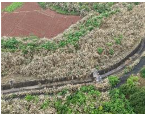
盐溪分干渠明渠
